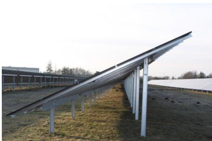
Figur 7. Montagesystem för solpaneler som har pålats.
