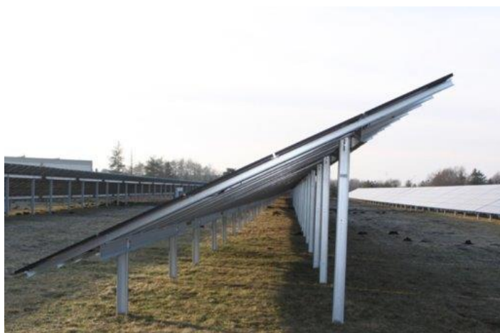
Figur 7. Montagesystem för solpaneler som har pålats.
