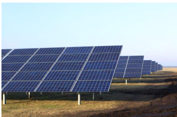
Figur 12. Exempel på ett fast system från Aerocompact.
