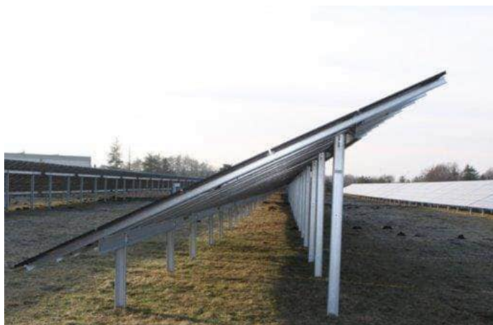
Figur 6. Montagesystem för solpaneler som har pålats.
