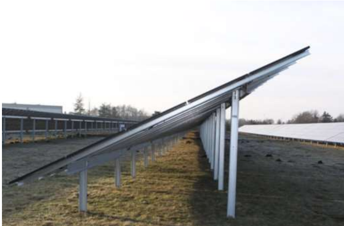
Figur 5 Montagesystem för solpaneler som har pålats.
