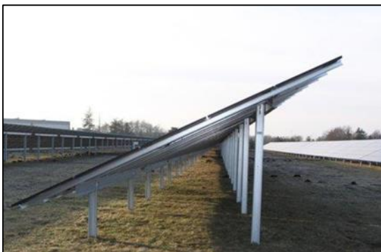
Figur 30. Montagesystem för solpaneler som har pålats.
