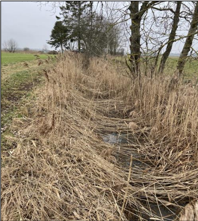
Figur 9: Öppet vattenförande dike längs södra halvan av västra fastighetsgränsen. Bilden är tagen av Soltech.
