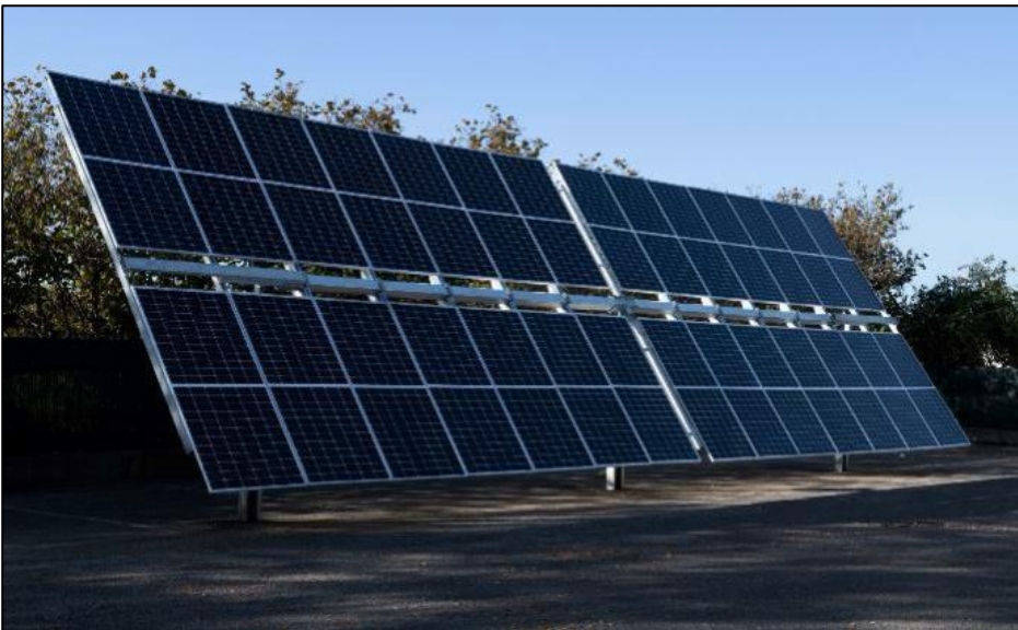
Figur 16. Exempel på ett trackersystem från Convert Italia.
